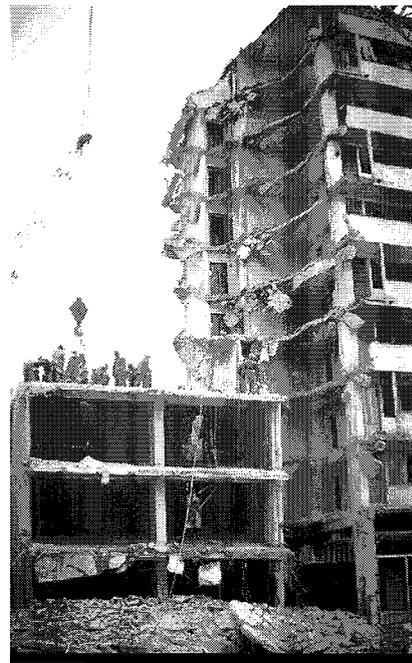
Colapsul parțial și înclinarea pronunțată a tronsonului de colț al blocului 30 din Șoseaua Ștefan cel Mare 33, structură de tip „parter flexibil” sau „slab”. Demolarea tronsonului afectat a fost obligatorie (București, 1977)
