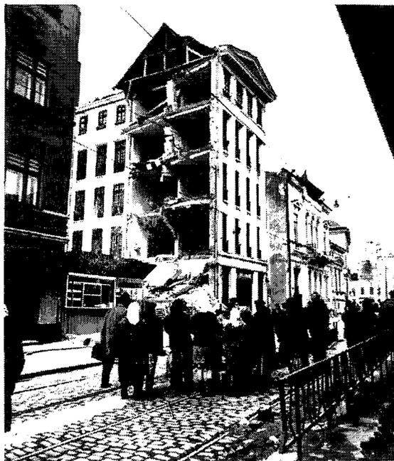
Prăbușirea parțială a unei clădiri cu structura din zidărie și beton armat în 1977.
