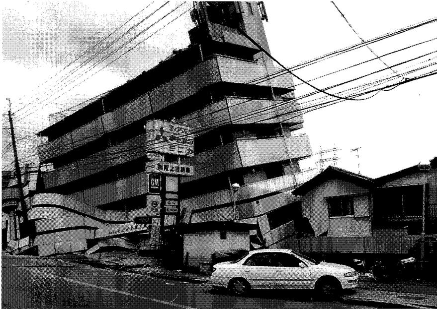
Colapsul construcției la primele două niveluri. Se impune demolarea ei.
